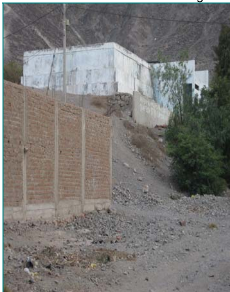
Foto N° 012 Vista del Reservoir Vista Alegre
