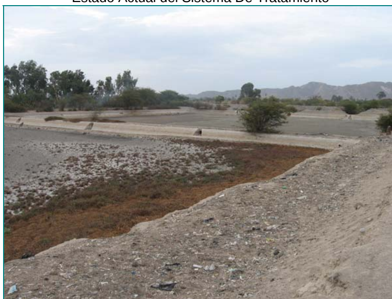
Foto N° 020 Estado Actual del Sistema De Tratamiento
