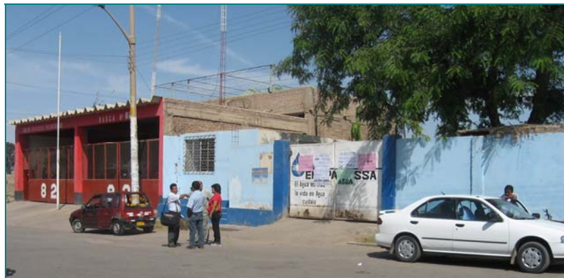
Foto N° 022 Vista de la Instalación de la EPS EMAPAVIGSSA
