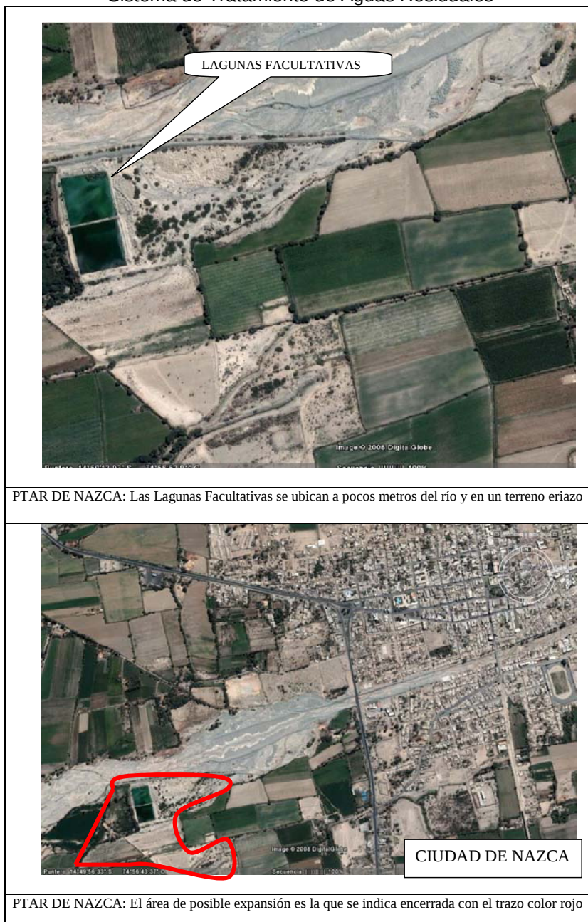
Foto N° 021 Sistema de Tratamiento de Aguas Residuales
