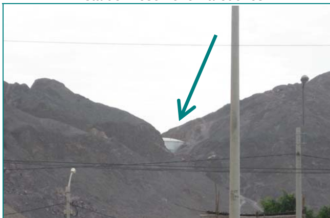
Foto N° 016 Vista del Reservorio Paredones
