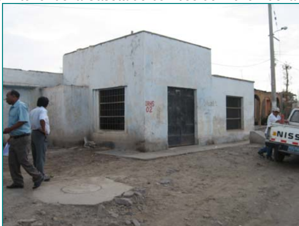
Foto N° 010 Vista Exterior de la Caseta de bombeo del Pozo Nueva Unión
